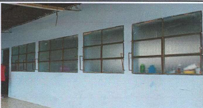
Aplicación de pintura en paredes bajo cubierta nueva (color a elegir)
