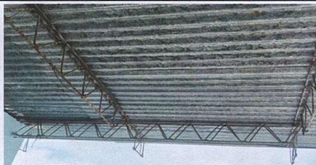
Suministro y colocación de vigas galvanizadas, costanera galvanizada, lamina troquelada.
