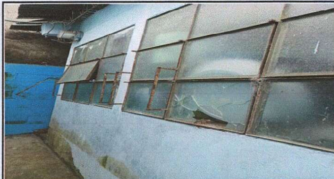
Sustitución de ventanas y pintura en cuanto estén colocadas las ventanas nuevas.
