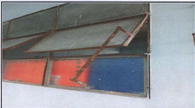
Sustitución de ventanas
